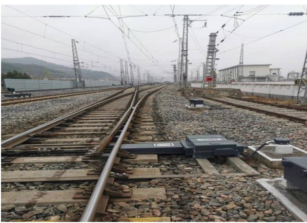
专用线起点（郴州西站附近）
