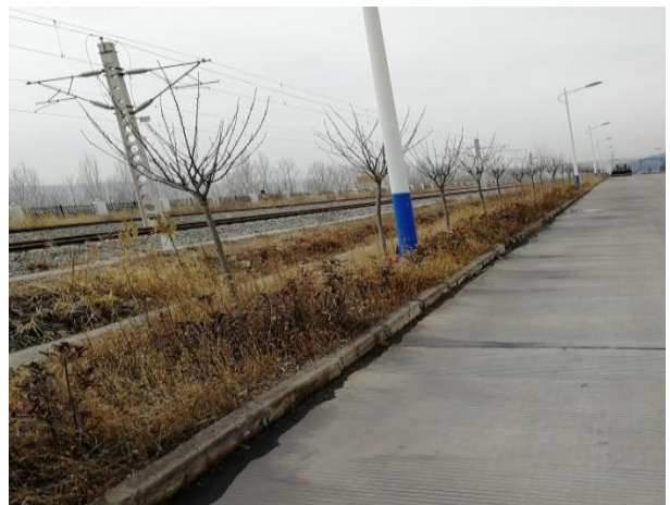
铁路专用线沿线绿化
