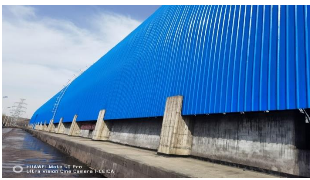
全封闭中转煤场
