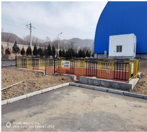
初期雨水收集池
