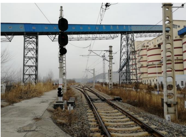
麻园子铁路专用线物流公司场内段
